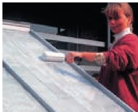
Затеняющая паста - Нанесите пасту снаружи на стекла при помощи валика или малярной кисти. Отлично защищает растения от солнца, для удаления пасты используйте жидкость для очистки теплиц.
